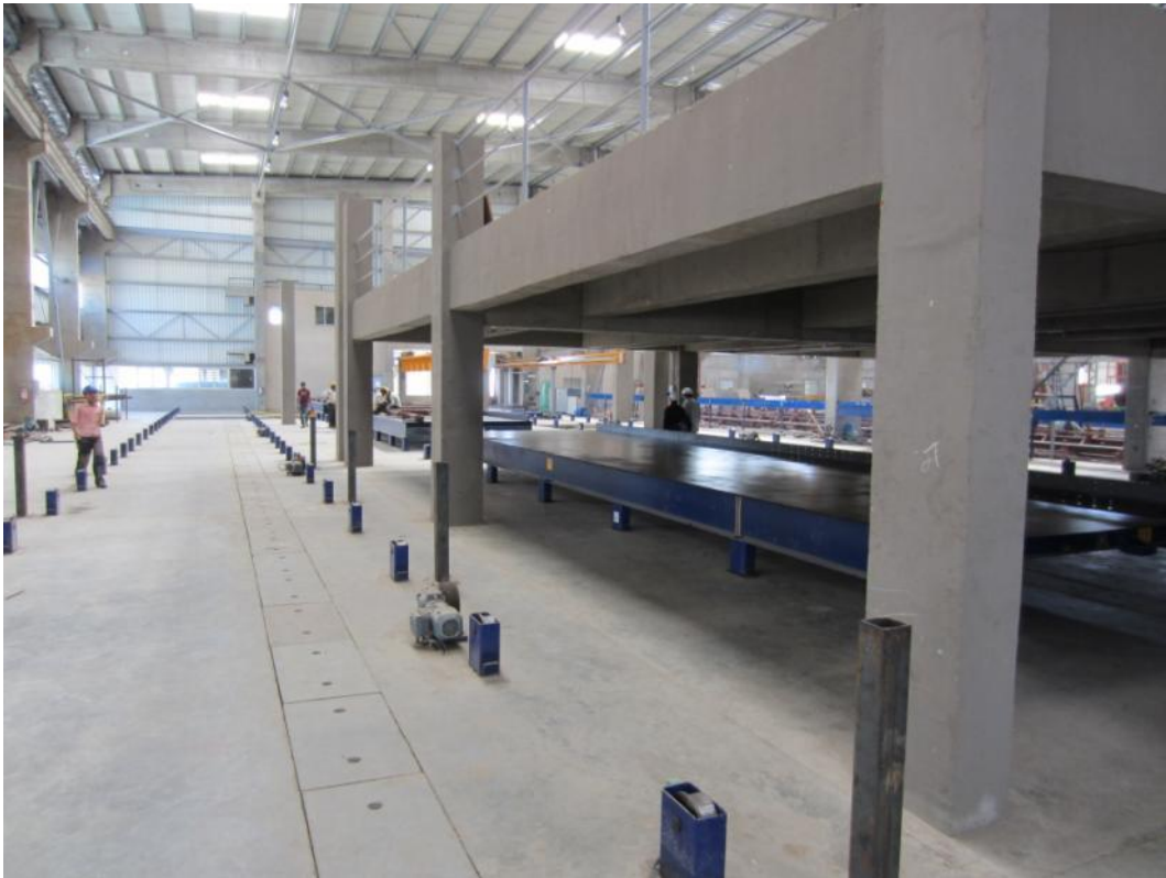
Fig. 10: 平行生产线使的预制混凝土部件的生产更为灵活多变
