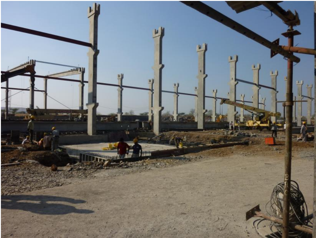
Fig. 3: 正在建造中的新生产厂
