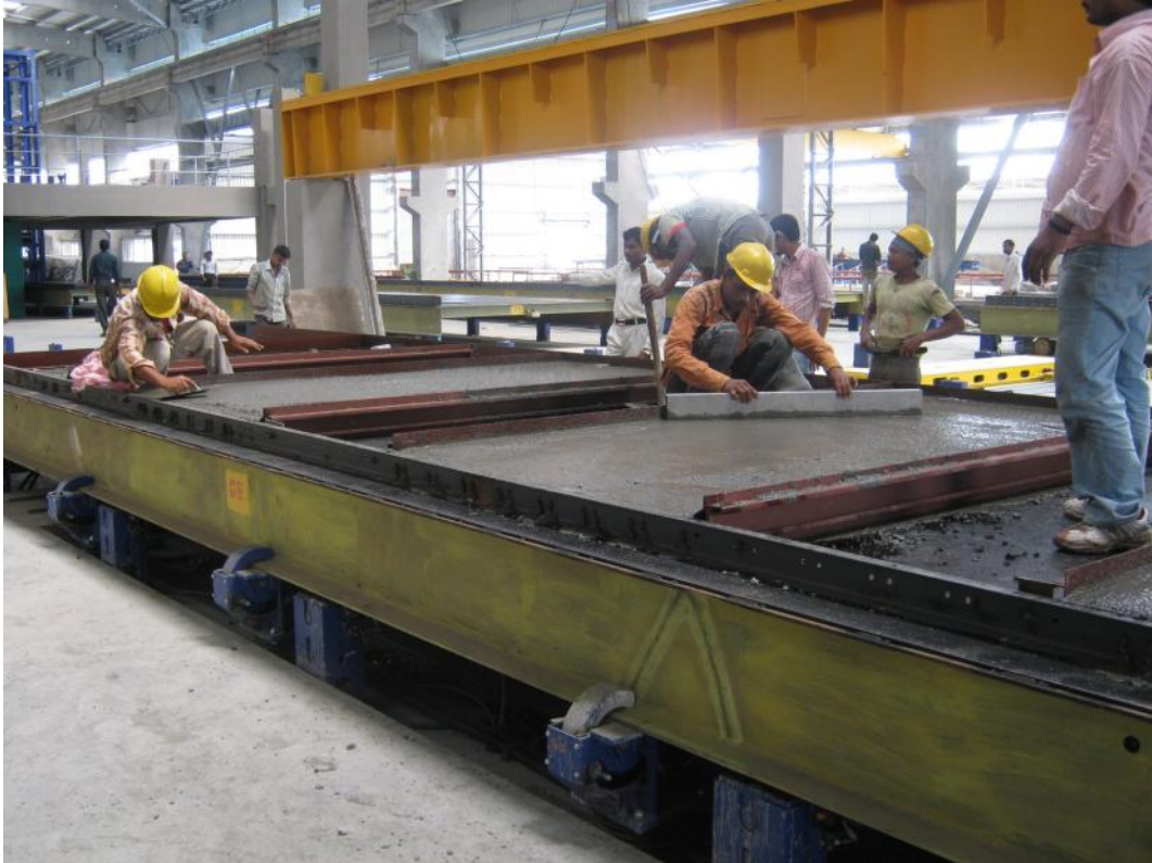
Fig. 15: 人工抹平混凝土表面
