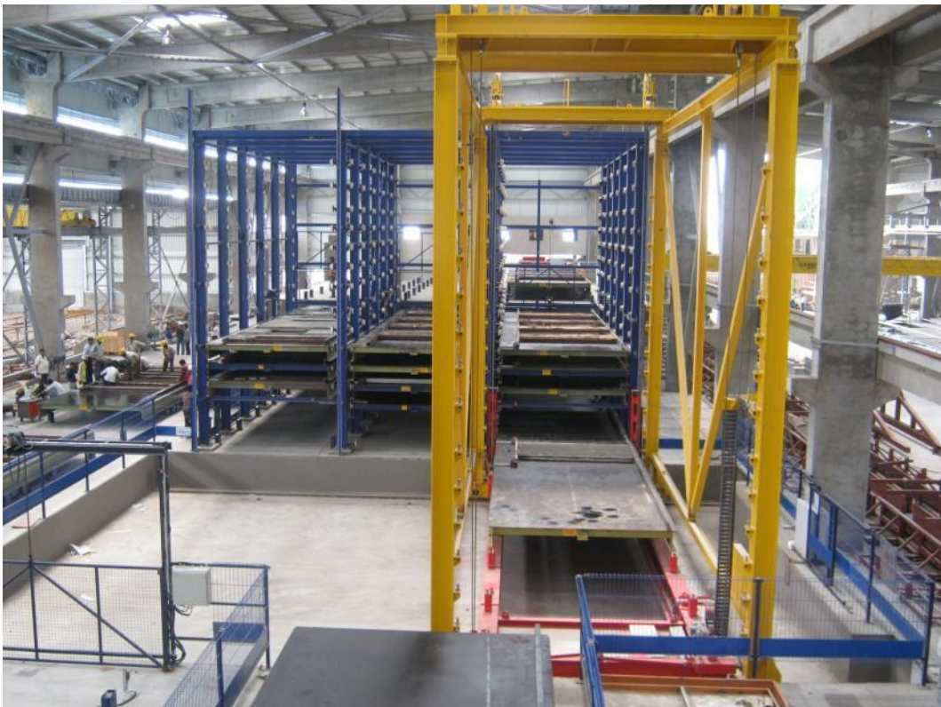
Fig. 12: 自动存储和检索设备运送托盘进出固化室
