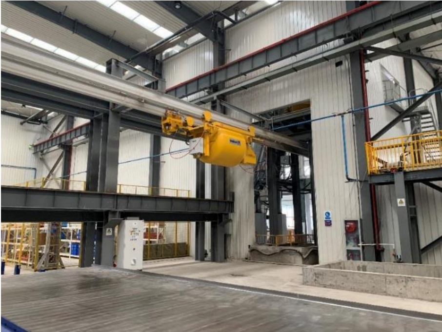
图 7 通过专门设计的鱼雷罐输送系统进行浇筑。
