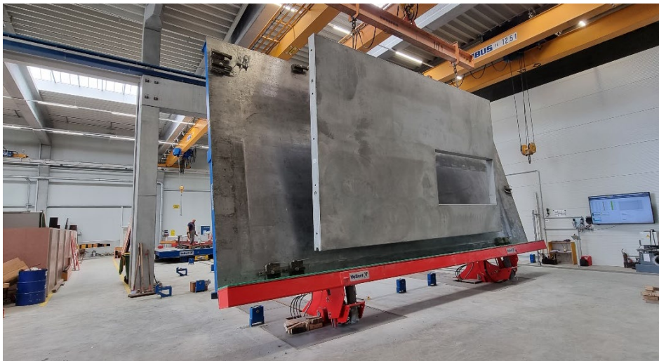
图11: 墙板的垂直提升由Vario TILT高性能倾斜站完成。
