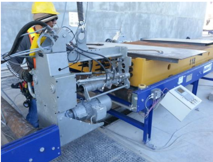
Fig. 2: 随后，利用螺栓拉伸器为钢丝施加预应力，同时不间断地监控、记录每根钢丝在这一过程中的紧固力矩
