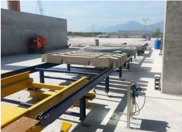
Fig. 5: 这些成型的预应力混凝土轨枕可以直接进行铺设
