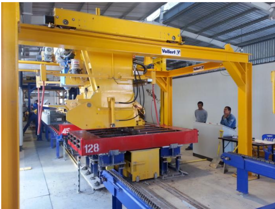
Fig. 6: 电动旋杆卸料装置将混凝土高精度地浇注至机械固定模具中
